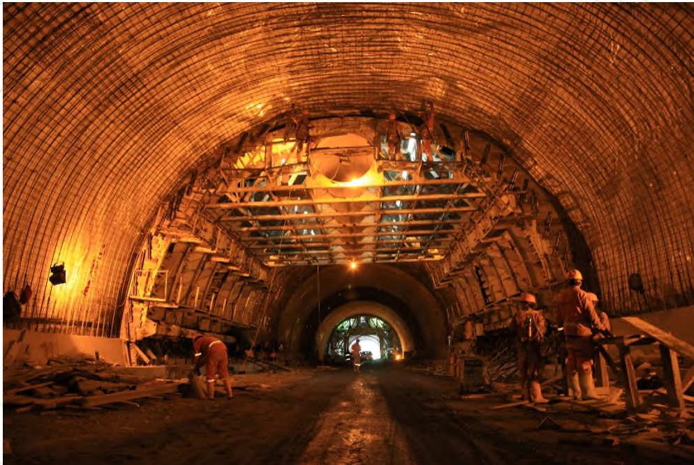
La Línea Tunnel. Taken from National Highway Institute (INVIAS) - < http://www.reporterosasociados.com.co >
